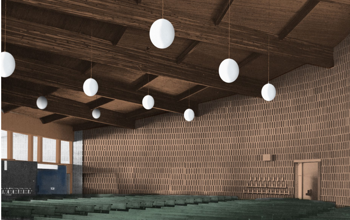
Σχήμα 2.32 Χρήση ειδικών διάτρητων ηχοαπορροφητικών τούβλων στην καμπυλόγραμμη πλευρική παρειά χώρου ακροατηρίου.
