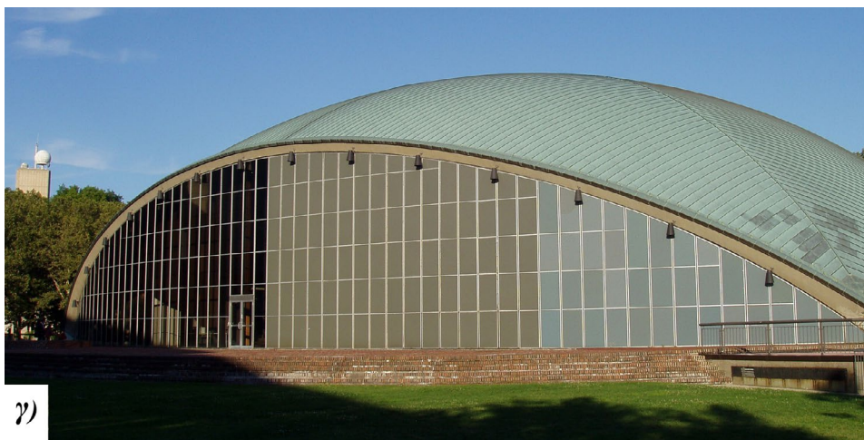
Σχήμα 2.31 Kresge Auditorium, Cambridge USA. Έτος 1955, \approx 1250 άτομα. Αρχ/των: E. Saarinen, Σύμβ. ακουστικής: Bolt, Beranek, Newman. α) Τομή κατά μήκος, β) Εσωτερική άποψη. (© Beranek, 1962). γ) Εξωτερική άποψη. (en. wikipedia.org). Το τρουλλοειδές κέλυφος δεν ταιριάζει λειτουργικά στον εσωτερικό χώρο. Είναι όμως εμπνευσμένο μονοσήμαντα από το ένστικτο του αρχιτέκτονα για καθαρές μορφές με απέριτο χαρακτήρα.
